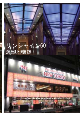
ニューウキョウ日暮里店 外壁全改装工事/FF行灯 LEDチャンネル文字/スパンド貼
