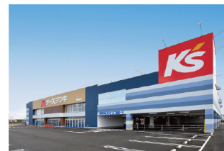
店舗 サイン工事
