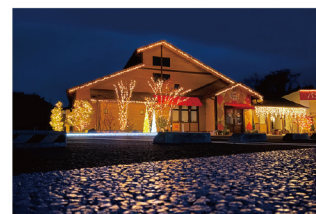
店舗 イルミネーション工事
